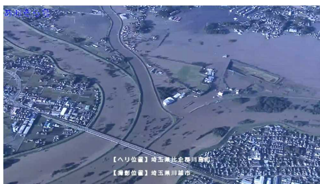
越辺川堤防決壊による浸水状況 (埼玉県川越市) 10/13 撮影 関東地方整備局提供
