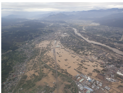
千曲川堤防決壊による浸水状況 (長野県長野市) 10/14 撮影 長野県長野市穂保地先(信濃川水系千曲川 58K 地点) 北陸地方整備局提供
